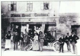
7. April 1901, Empfang des Busses in Gablitz nach der 2. Eröffnung der Linie von Purkersdorf aus. Rechts von der Frau stehend: Adalbert Herrmann, Chef der Betriebsgesellschaft
